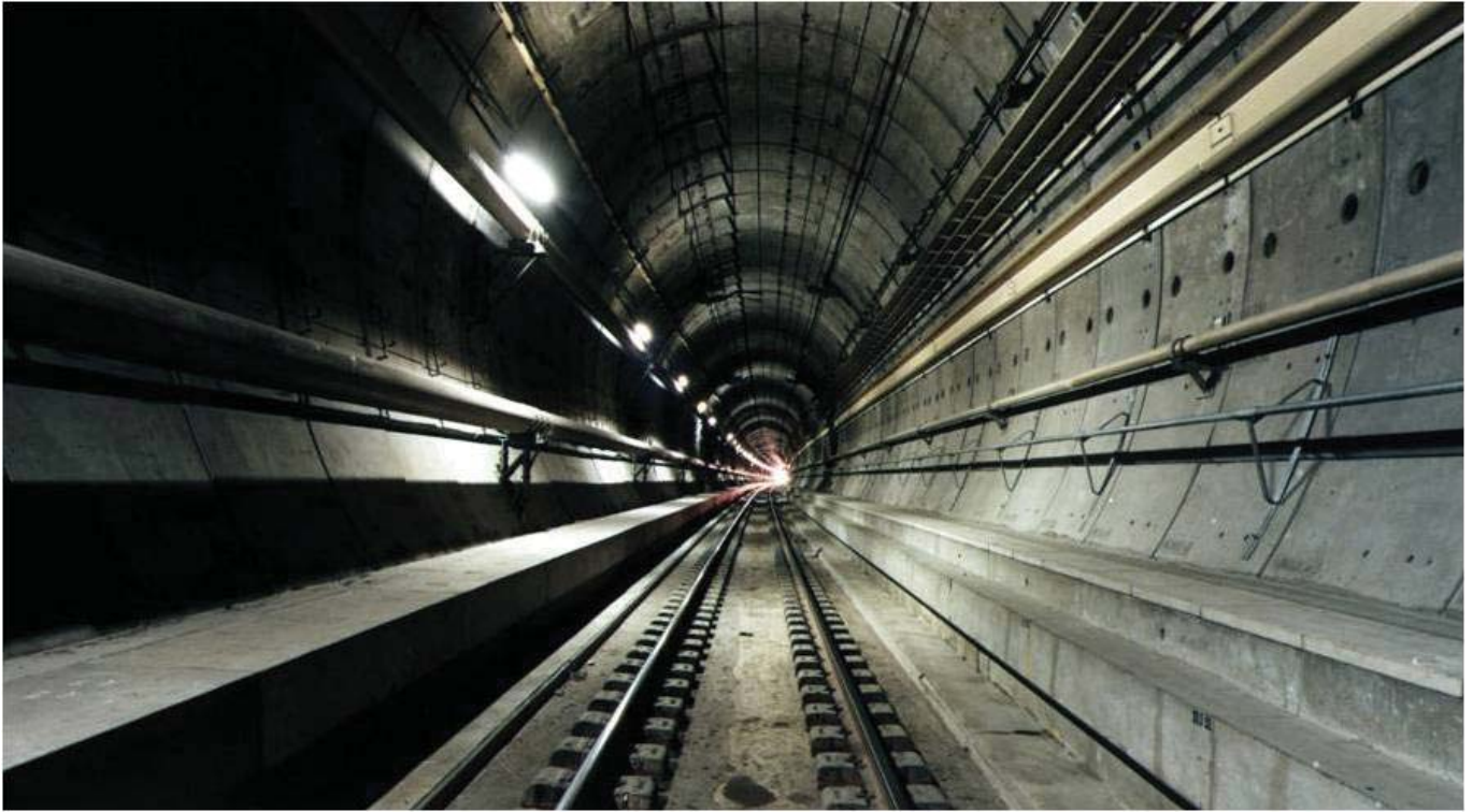
其中一条火车隧道的内部情景
