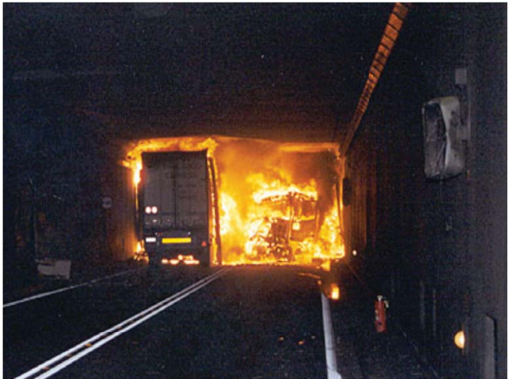
公路隧道火灾对人和隧道带来灾难性损伤
