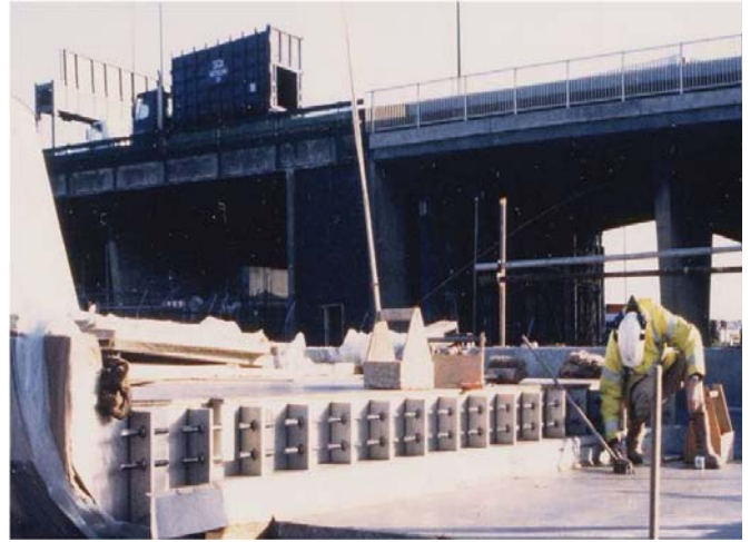
英国达特福德河隧道安装了不锈钢面板来抵抗除冰盐的腐蚀。
